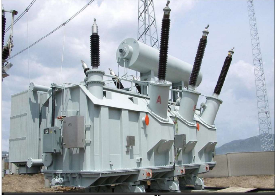
Şekil 1.6: Güç trafosu 29
