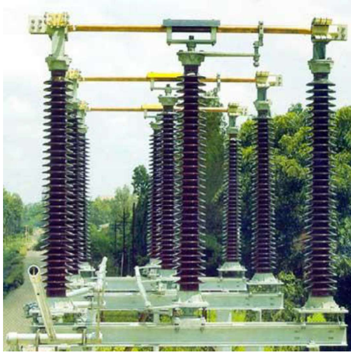
Şekil 1.8: Yüksek gerilimde kullanılan izolatör 34
