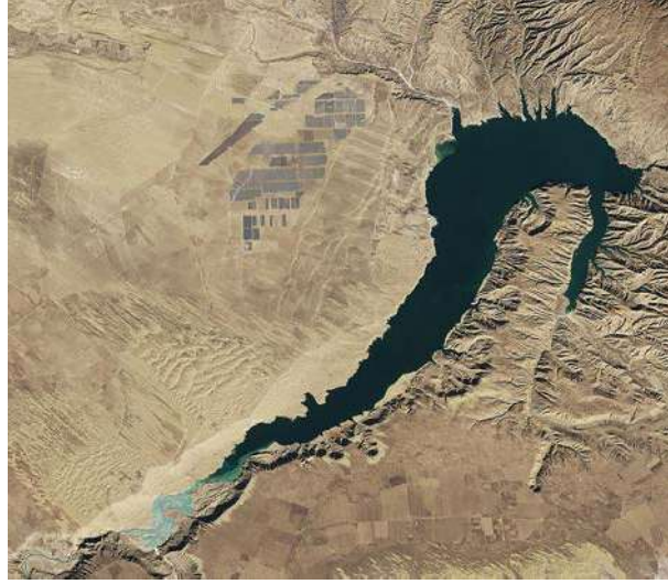
Şekil 2.16: Longyangxia hidroelektrik santrali ve Gonghe güneş enerjisi santralinin yer aldığı hibrit sistemin uzaydan alınan görüntüsü 155
