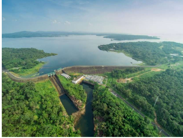
Şekil 2.22: 45 MW'lık YFV Tesisin Kurulacağı Sirindhorn Barajı 176
