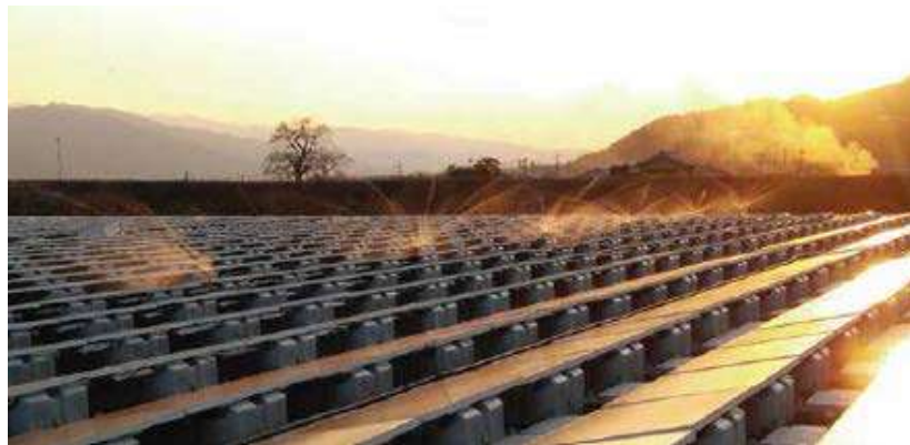
Şekil 2.9: YFV Sisteme Uygulanan Aktif Soğutma Çözümü
