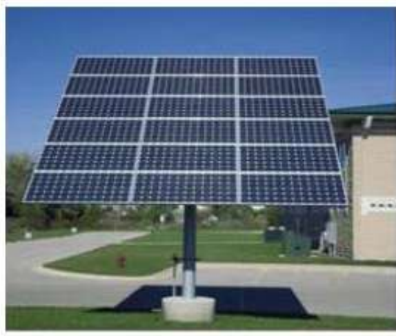
Şekil 1.11: Arazi Kurulumlu Fotovoltaik Sistem Örneği 112
