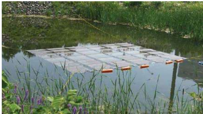
Şekil 2.8: Kanada’da 0,57 kW Gücünde Yarı Batık Yüzen İnce Film Sistemi
